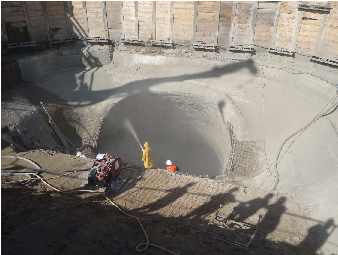
Obr. č. 3: Realizace prací – úprava koryta a rozdělovacího objektu před nátokem do Pasecké štoly (objekt SO 01)
