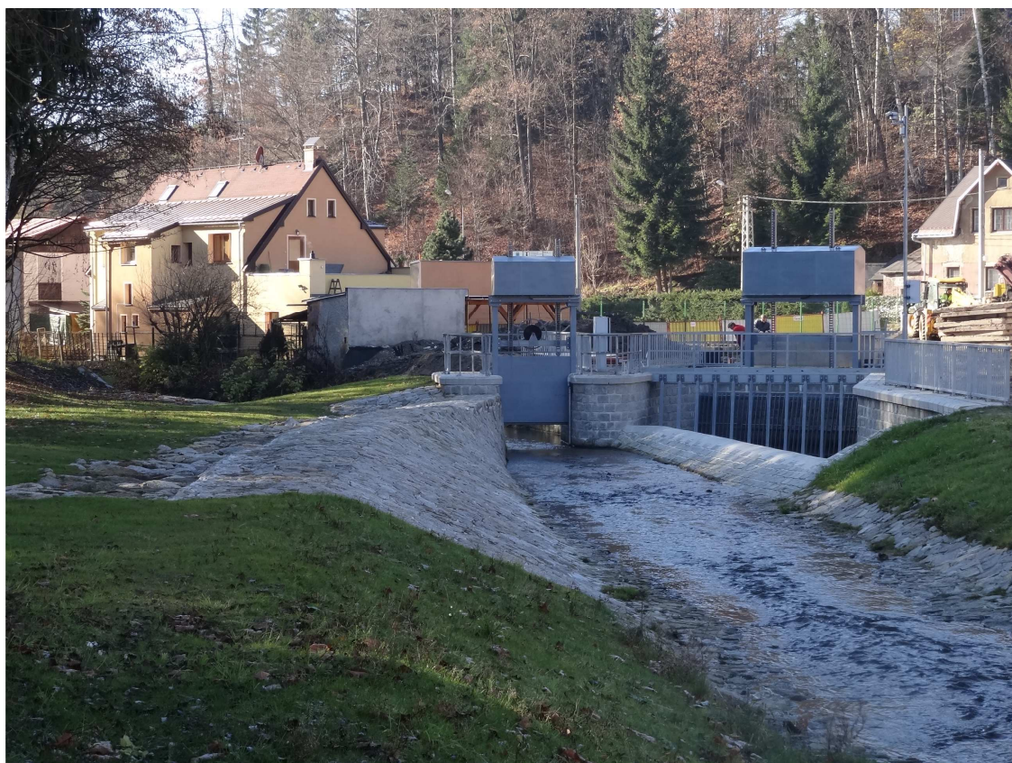
Obr. č. 5: Dokončená úprava rozdělovacího objektu před nátokem do Pasecké štoly (objekt SO 01)
