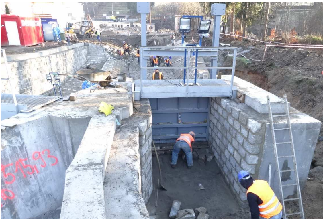
Obr. č. 3: Realizace prací – úprava koryta a rozdělovacího objektu před nátokem do Pasecké štoly (objekt SO 01)
