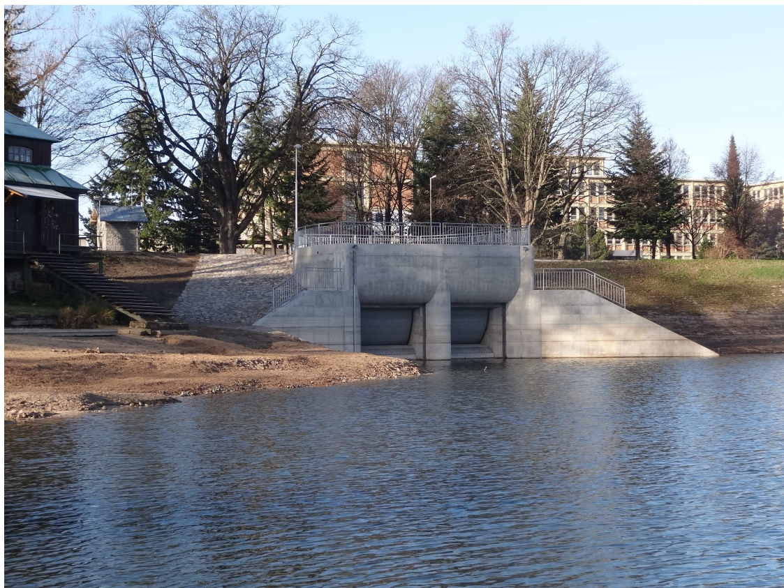
Obr. č. 5: Dokončená úprava rozdělovacího objektu před nátokem do Pasecké štoly (objekt SO 01)
